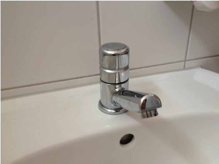
Die nachträglich eingebauten Anlagen im Sanitärbereich, sind mit Wasserspareinsätzen ausgestattet.
