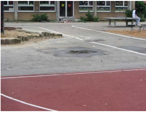
Belagsschäden im oberen Pausenhof
