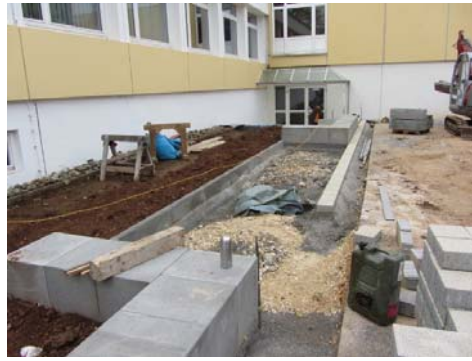
Aktuell: Sanierung des Pausenhofes
