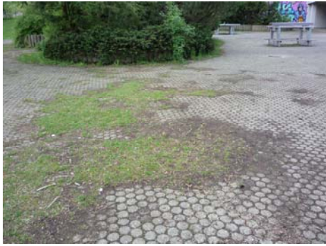
Sanierungsbedürftiger Betonpflasterbelag Typ „Rondo“
