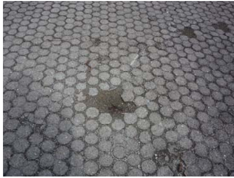
Sanierungsbedürftiger Betonpflasterbelag Typ „Rondo“
