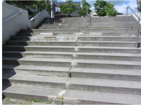
Treppenanlage zum Gymnasium
