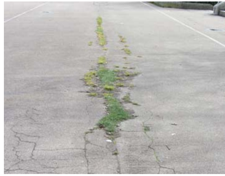
Belagsschäden Asphaltbelag
