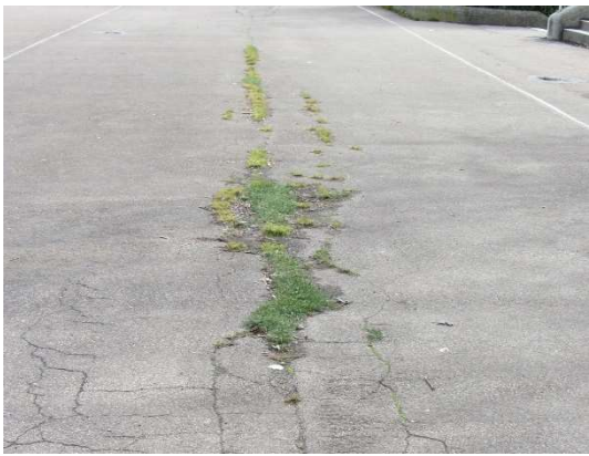
Belagsschäden Asphaltbelag
