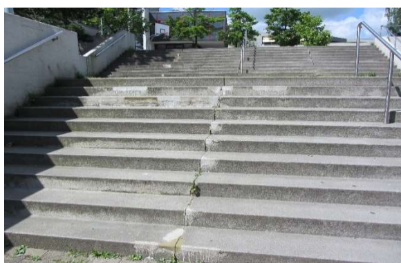
Treppenanlage zum Gymnasium
