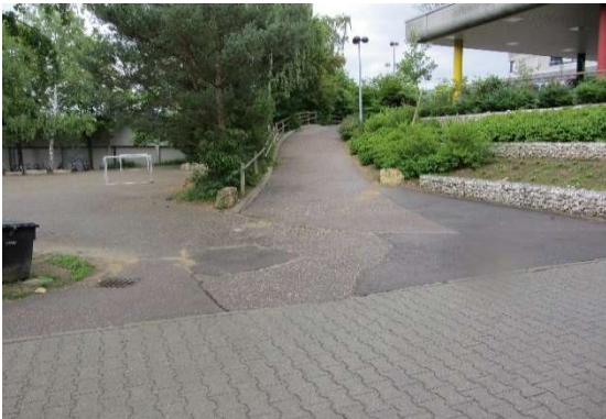
Belagsschäden im Bereich Realschule
