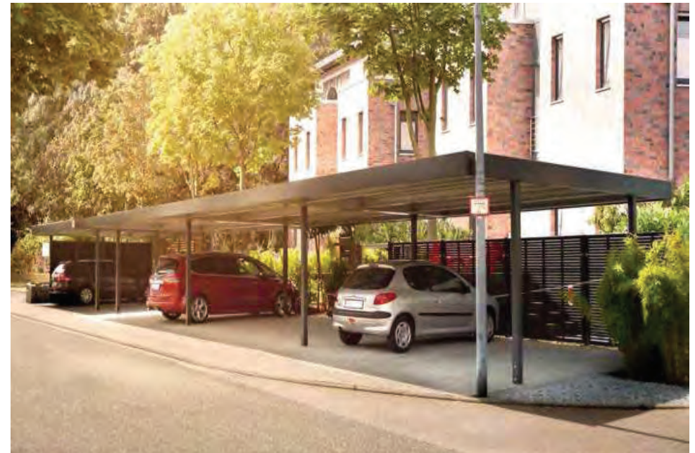
Abb. 67 transparent gestaltete Carportanlage, Fa. Siebau Raumsysteme
