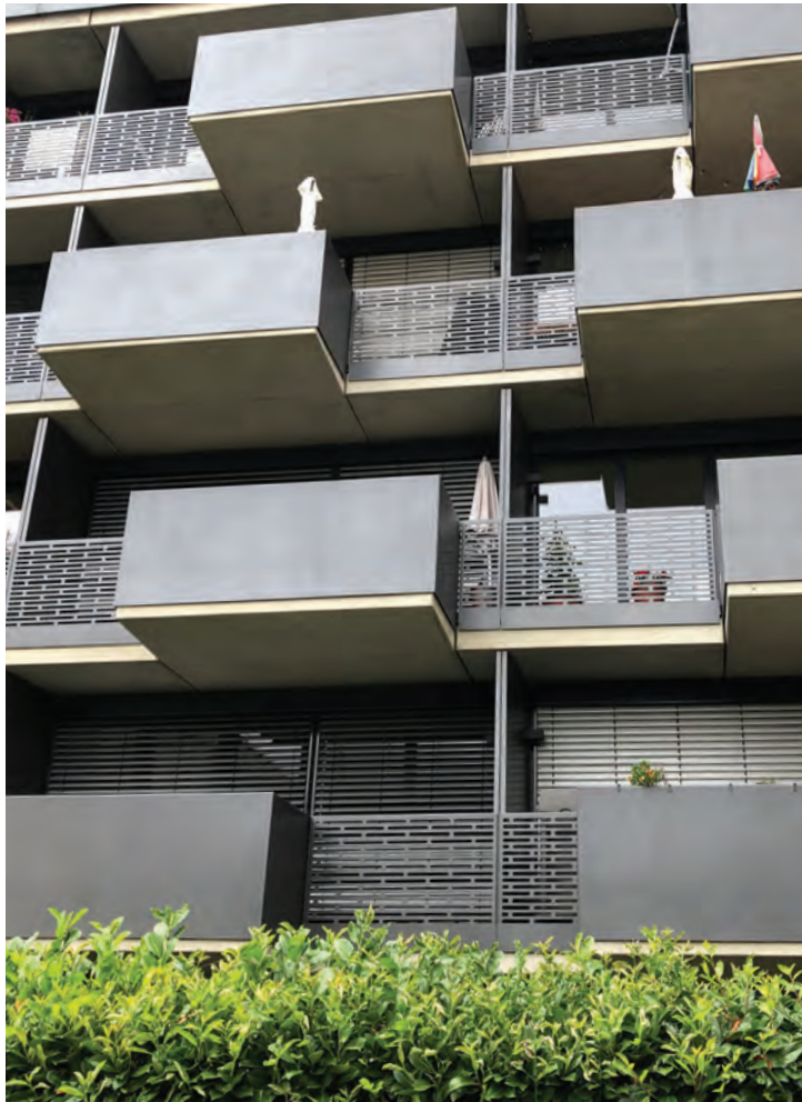
Abb. 43 Übergang geschlossen - transparent, bottega ehrhardt Architekten, Weimarstraße Stuttgart
