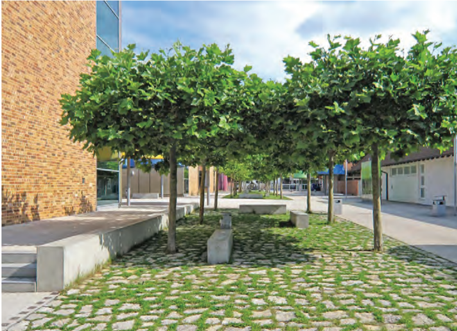
Abb. 52 wasserdurchlässig gestaltetes Natursteinpflaster mit Baumdach, Peter-Bruckmann-Schule Heilbronn
