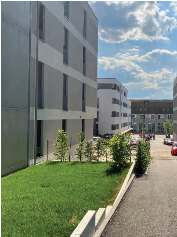
Abb. 68 Tiefgaragendachbegrünung und begrünte Rampenabfahrt, Stadtoval Aalen
