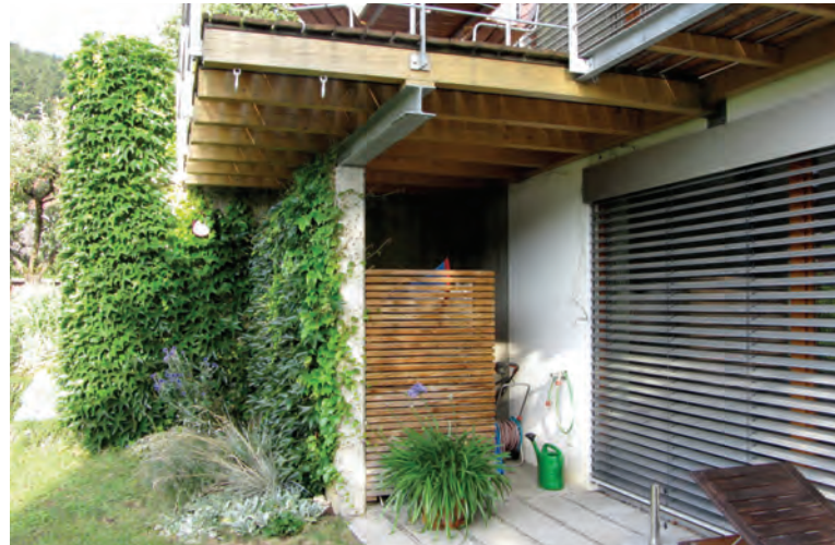
Abb. 44 begrünte Fassade und Loggia mit verdeckt gestalteten Lagerflächen, Aalen
