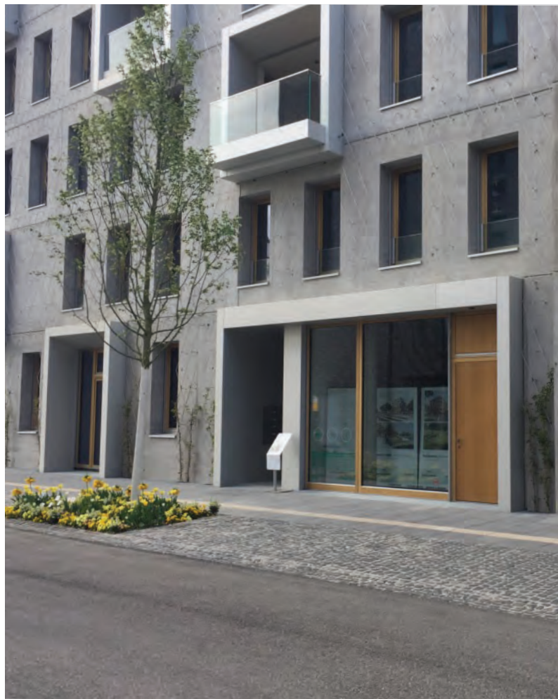
Abb. 22 mehrere Gebäudeeingänge, Bahnstadt Heidelberg
