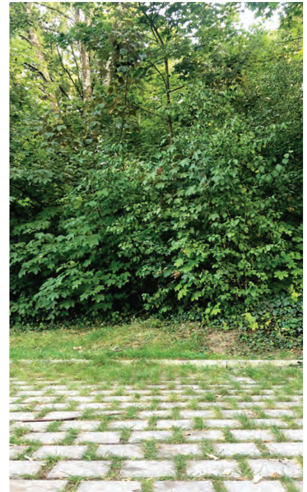
Abb. 61 wasserdurchlässiger Bodenbelag, Stadt Aalen
