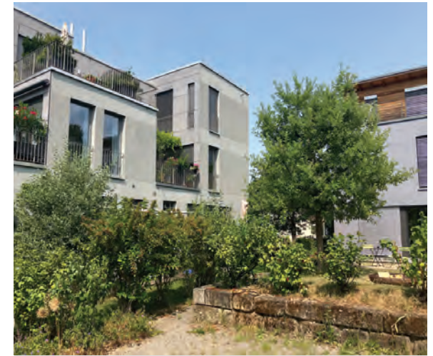
Abb. 32 Trockenmauer als Einfriedungselement, Tübingen
