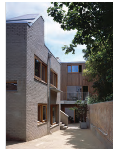
Abb. 24 Zugänge, Henley Halebrown Arch.
