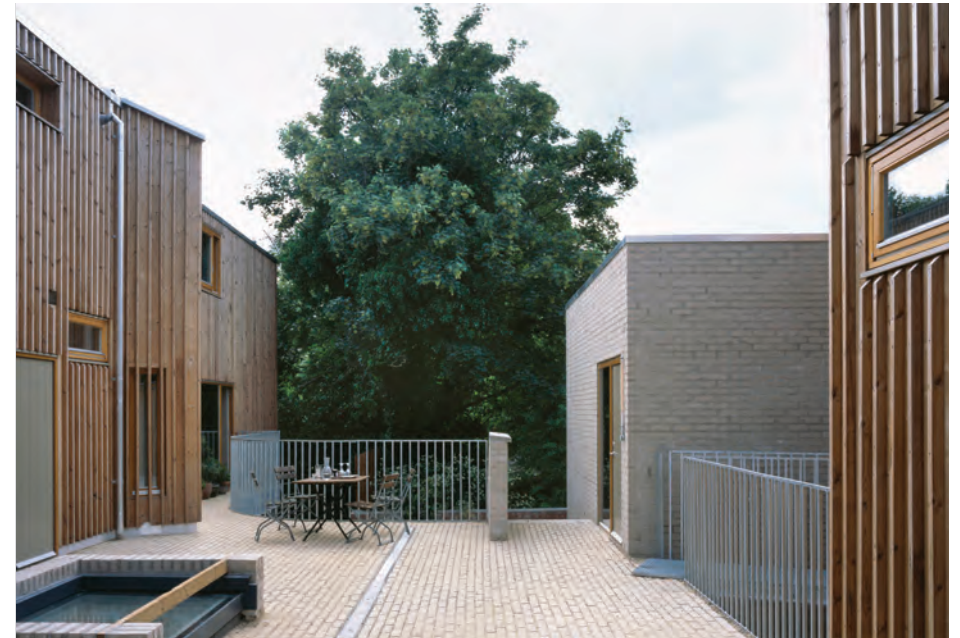
Abb. 53 gepflasterte Hoffläche auf Tiefgarage, Copper Lane, Henley Halebrown Arch.
