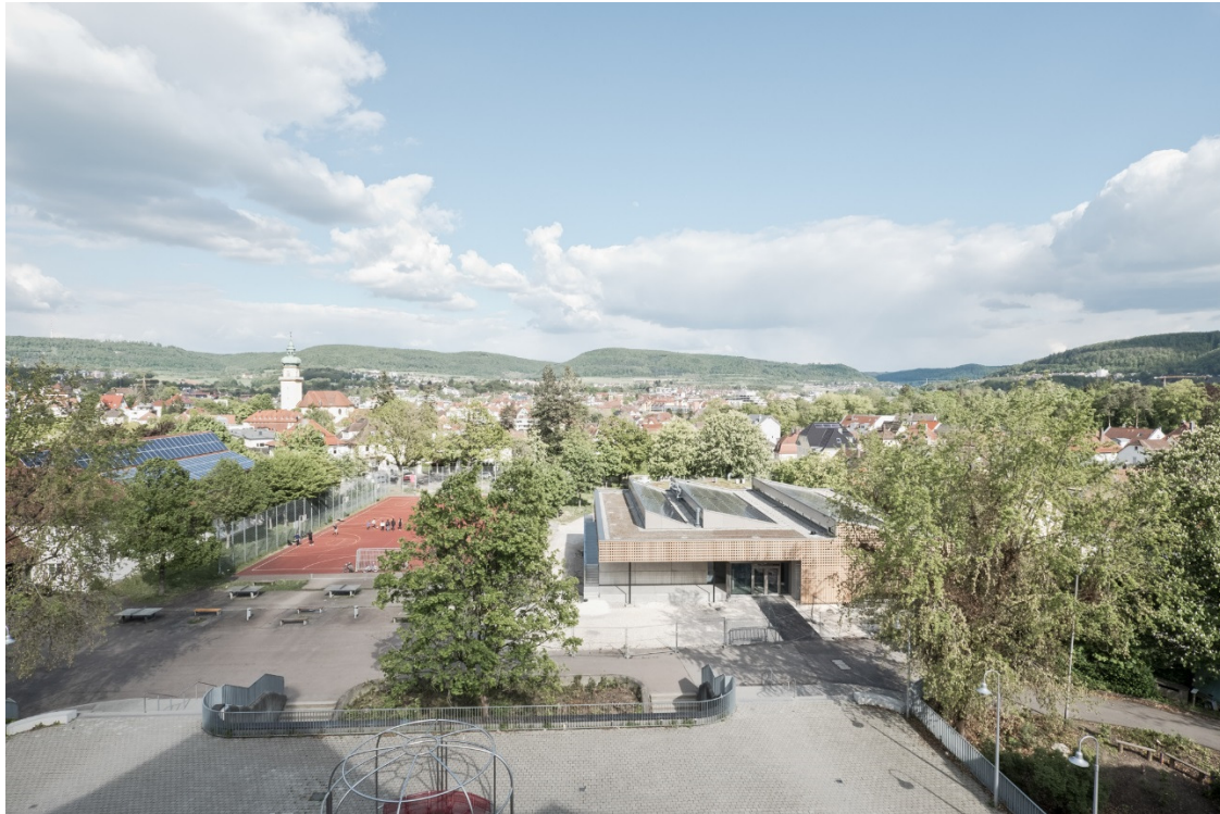
Abbildung 34: Fachklassentrakt des Schubart-Gymnasiums (Foto Liebel-Architekten)
