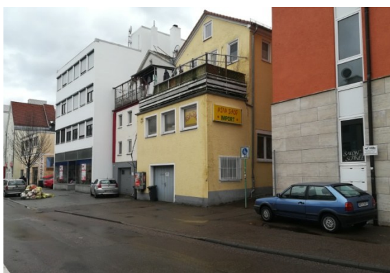
Foto 21: Nördlicher Stadtgraben- Sanierungsbedarf
