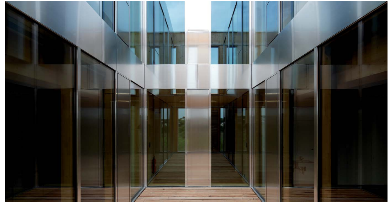
Lichthof für eine schallgeschützte Lüftung der Labore
