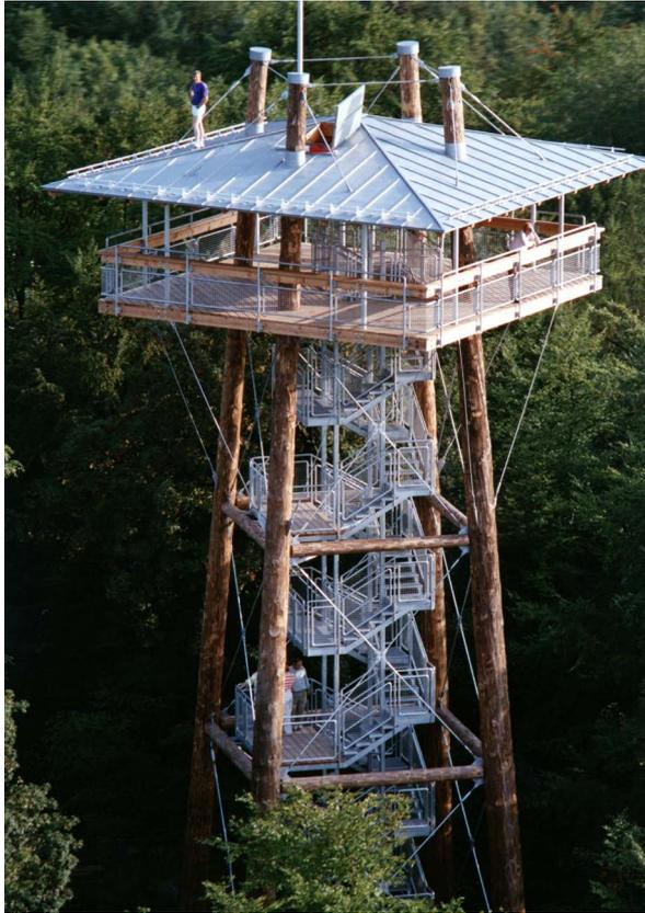
Abb. 16: Die Metall-Holzkonstruktion im fertigen Zustand.
