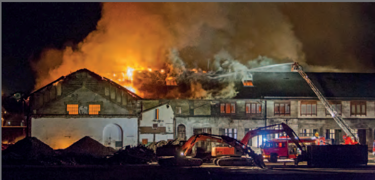
Großbrand im ehemaligen Bahnausbesserungswerk 2014
