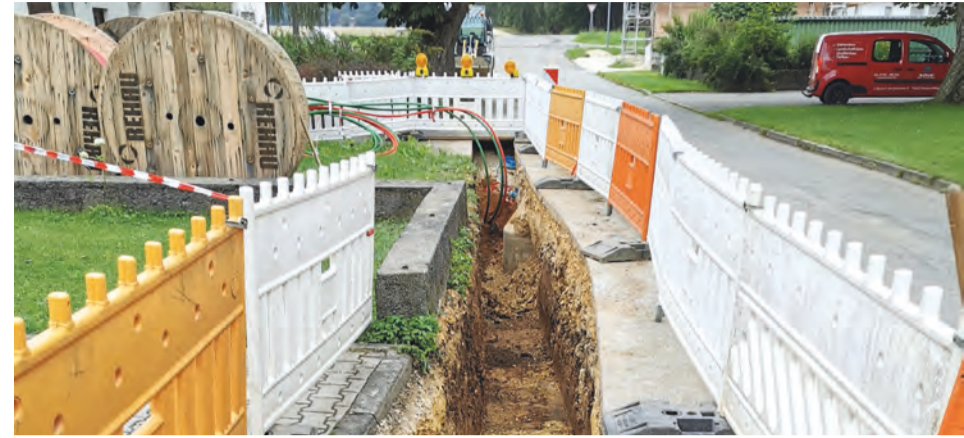
Verlegen von Glasfaserrohren in Aalen-Niesitz.
