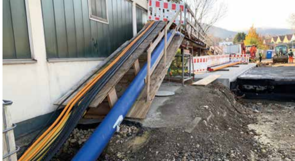
So sieht die Baustelle an der Burgstallstraße aktuell aus. In den kommenden Wochen werden die provisorischen Versorgungsleitungen rückgebaut. Foto: Stadt Aalen
