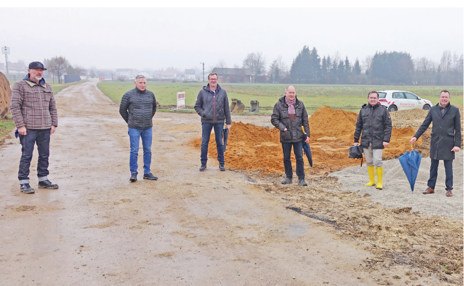
OB Thilo Rentschler (re.), Erster Bürgermeister Wolfgang Steidle (2.v.re.) und Ortsvorsteher Manfred Traub (3.v.li.) sowie Vertreter der Planer verschafften sich einen Überblick über die Arbeiten an der Nordumfahrung Ebnat (Blick in Richtung Ebnat). Foto: Stadt Aalen
