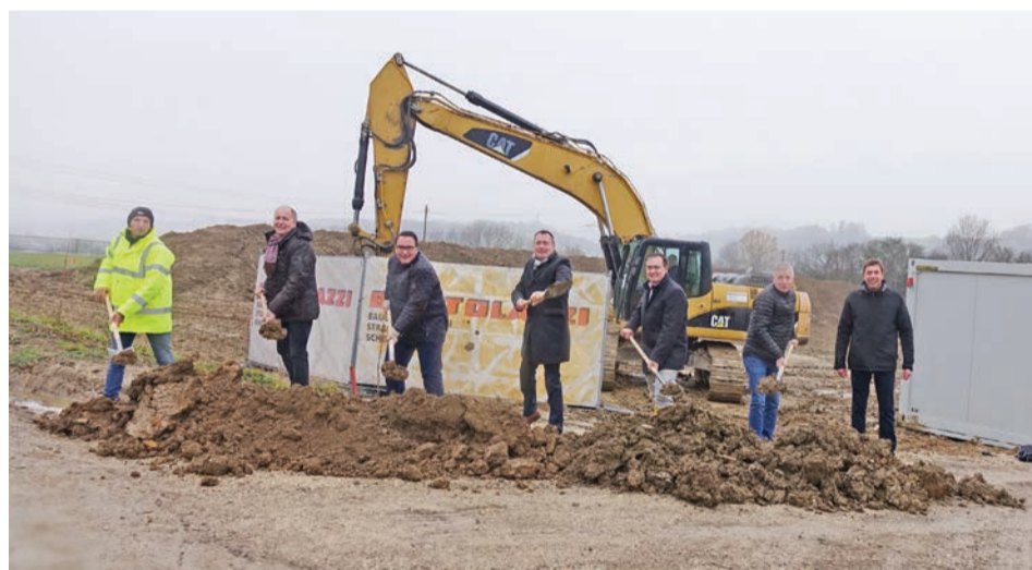
Beim Spatenstich mit OB Rentschler und Baubürgermeister Steidle und Ortsvorsteher Christian Wanner sowie den Baubeteiligten wurde der Startschuss für die Erschließung des Gewerbegebiets Staudenfeld gegeben. Foto: Stadt Aalen
