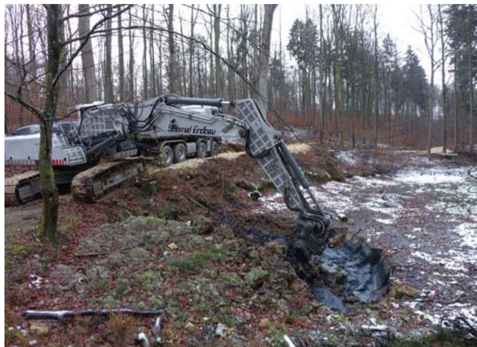
Der Schlamm aus dem Schwanenteich wird ausgebaggert.
