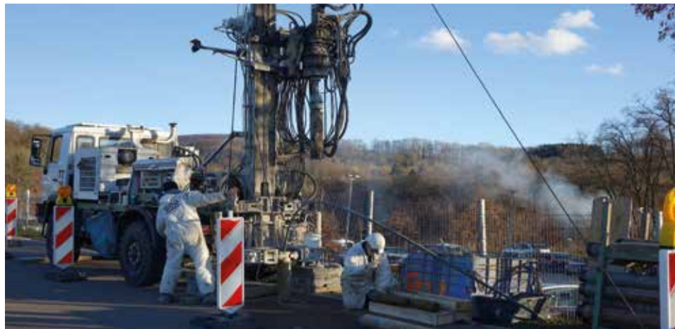
Die Erkundungsbohrungen im Bereich des Erzwegs haben begonnen.
