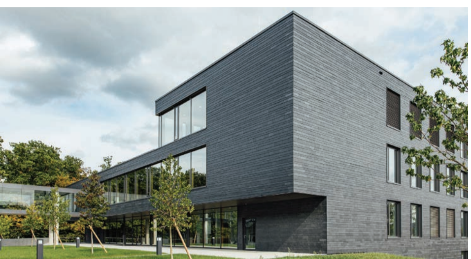
Die Neubauten der beiden Forschungsgebäude ZTN und ZIMATE ergänzen den Hochschulcampus.
