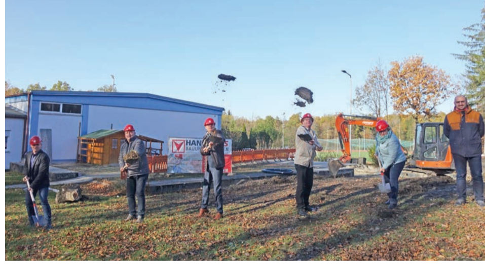
v.l.n.r. Dietmar King, Karl-Heinz Vandrey, Oberbürgermeister Thilo Rentschler, Bürgermeister Karl-Heinz Ehrmann, Erika Himml und Johannes Veit, Geschäftsführer der ausführenden Baufirma Hans Fuchs
