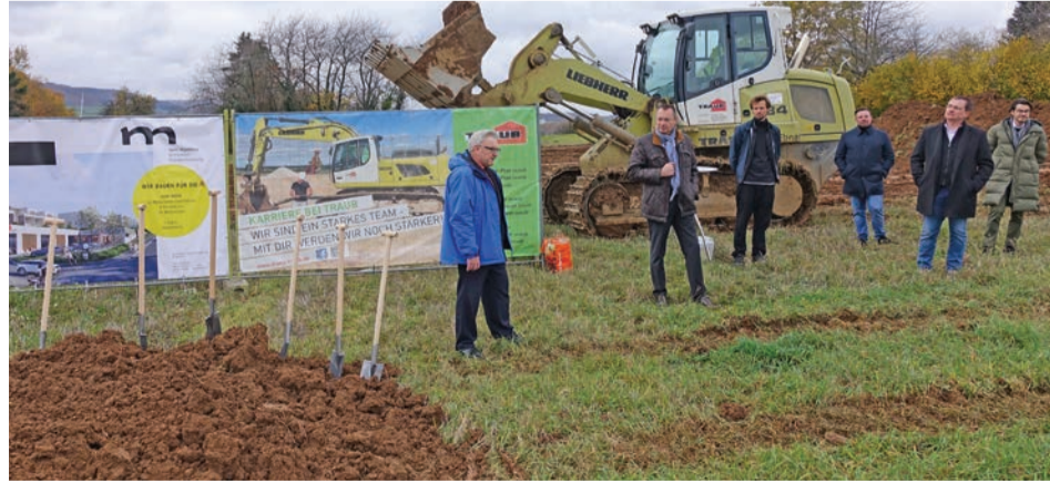
Im Gebiet Galgenberg-Ost gehen die Bauarbeiten los: Ein Tegut-Markt sowie das Wohnquartier LIAS entstehen als erste Projekte. OB Thilo Rentschler gab mit Erstem Bürgermeister Wolfgang Steidle und den Projektbeteiligten den Startschuss. Foto: Stadt Aalen
