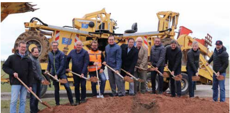
Der Spatenstich für die neue 20 kV-Leitung erfolgte unter großer Beteiligung Foto: Stadtwerke Aalen GmbH
