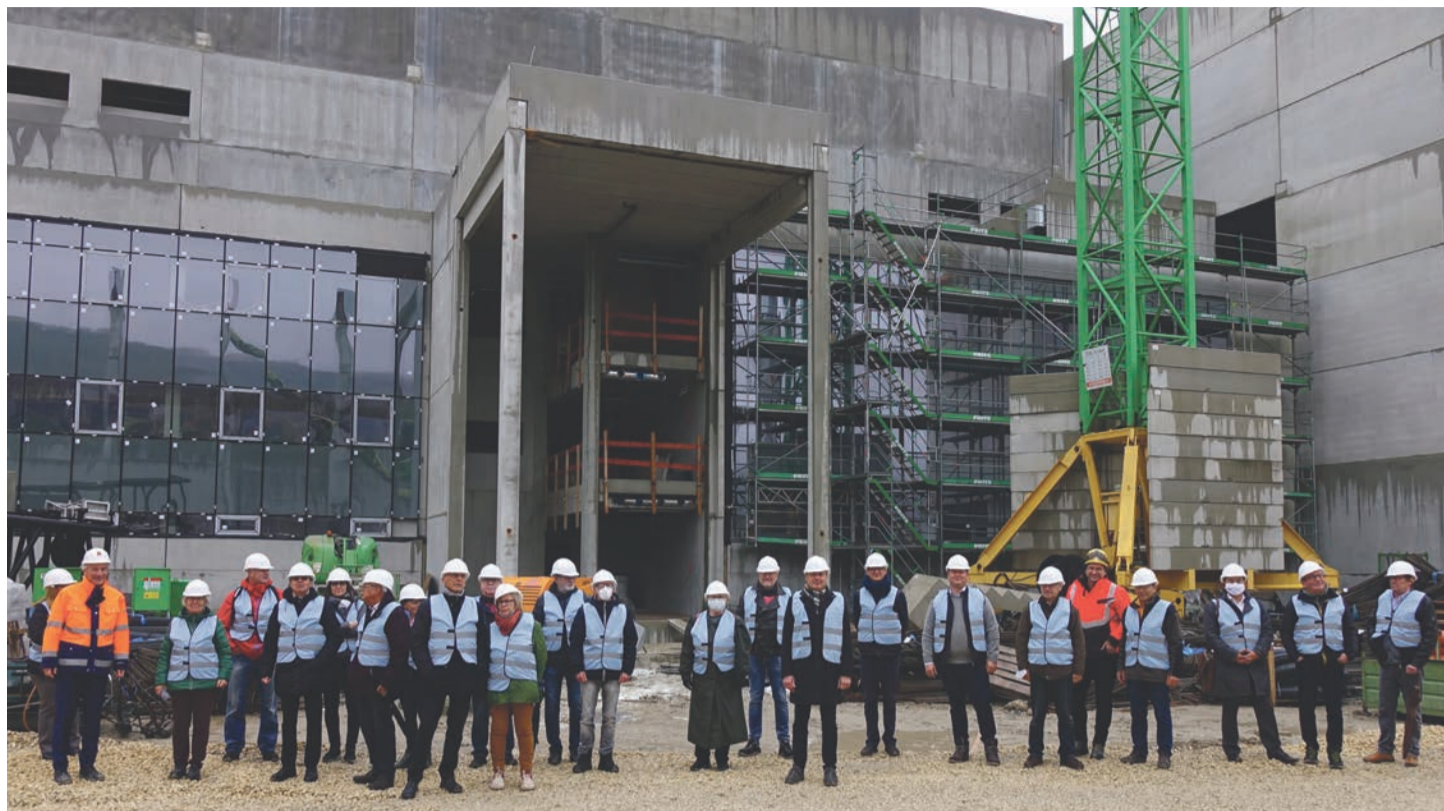
Beim Besuch auf der Palm-Baustelle konnten sich Gemeinderäte und die Verwaltungsspitze am 16. Oktober vom Fortschritt der umfangreichen Arbeiten überzeugen. Foto: Stadt Aalen
