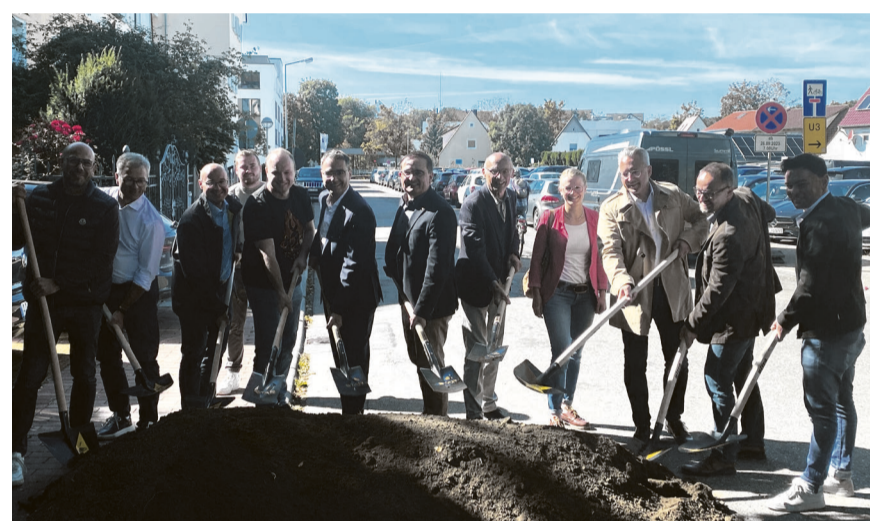
Mit einem symbolischen Spatenstich begannen die Arbeiten zur Umgestaltung der Schleifbrückenstraße. Foto: Stadt Aalen
