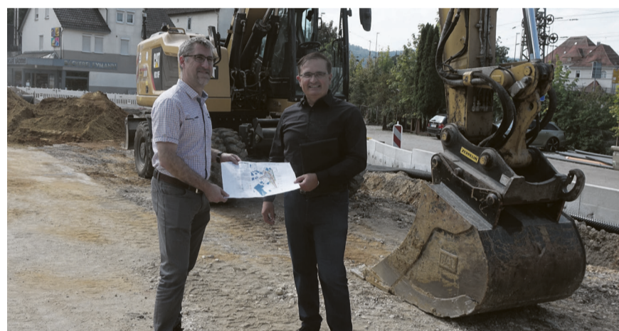
Erster Bürgermeister Wolfgang Steidle (r.) und Tiefbauamtsleiter Stefan Pommerenke (l.) auf der Baustelle des neuen Kreisverkehrs. Foto: Stadt Aalen
