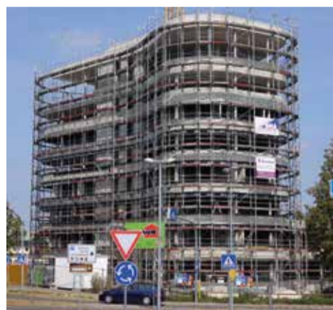
Der neue i Live-Tower am Burgstallkreisel. Foto: Stadt Aalen
