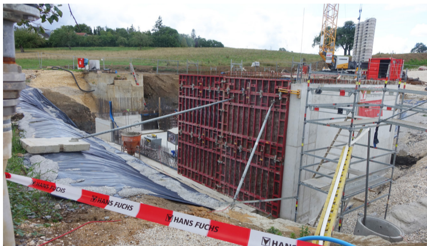
Die Bauarbeiten haben im Mai dieses Jahres begonnen
