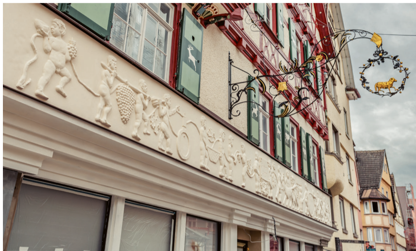
Das Kollektiv wird K die Arbeiten am Fries am ehemaligen Gasthaus Lamm erläutern.
