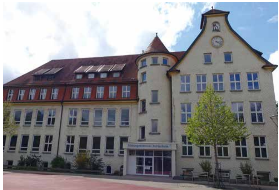
Die Bohlschule Aalen ist von der Denkmalstiftung als Denkmal des Monats Juni prämiert worden. Foto: Stadt Aalen
