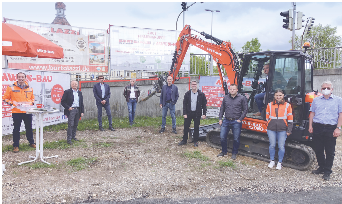
Baubürgermeister Wolfgang Steidle und Vertreter der am Bau beteiligten Firmen sowie der städtischen Ämter vollzogen den symbolischen Baubeginn der Arbeiten an der Unterführung zur Kettelerstraße. Foto: Stadt Aalen
