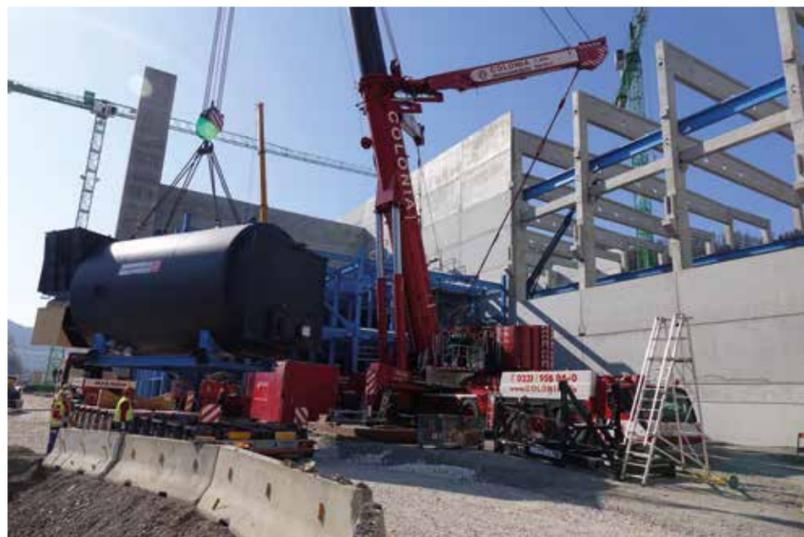
Einer der beiden neuen, 105 Tonnen schweren Dampfkessel wird am Kraftwerkshaus abgesetzt. Foto: Stadt Aalen
