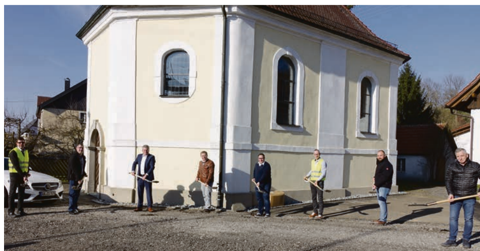
Mit dem symbolischen Spatenstich startet die dorfgerechte Umgestaltung der Ahelfinger Straße in Oberalfingen vor der Hubertuskapelle. Foto: Stadt Aalen
