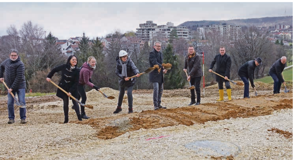
Mit dem symbolischen Spatenstich starteten OB Thilo Rentschler (4.v.re.), Wohnungsbau-Geschäftsführer Robert Ihl (Mitte), Baubürgermeister Wolfgang Steidle (3.v.re.), am Bau beteiligte Firmenvertreter und Aufsichtsräte den Bau von elf Reihenhäusern.
