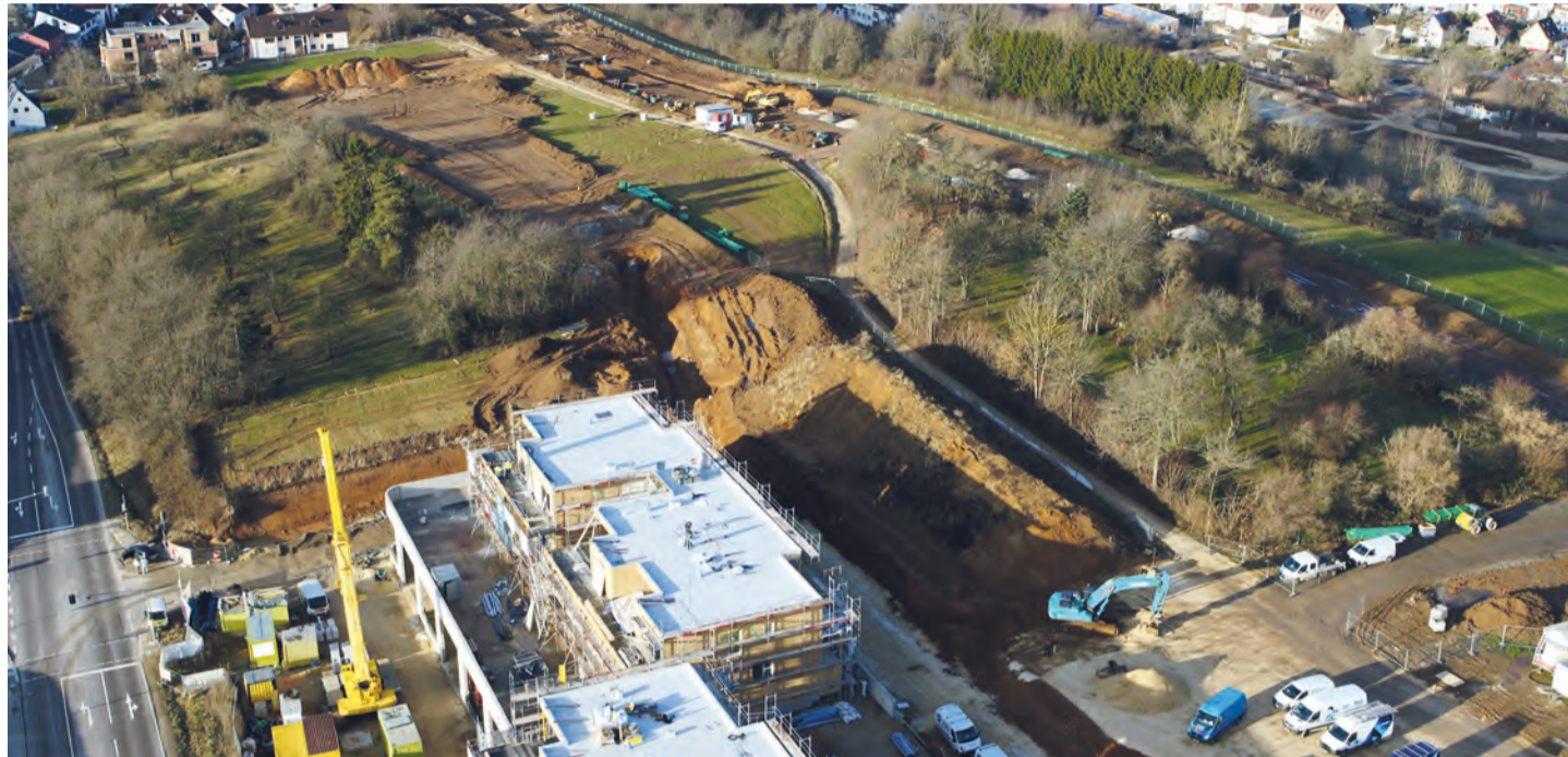
Blick auf den entstehenden tegut-Markt und die laufenden Erschließungsarbeiten.
