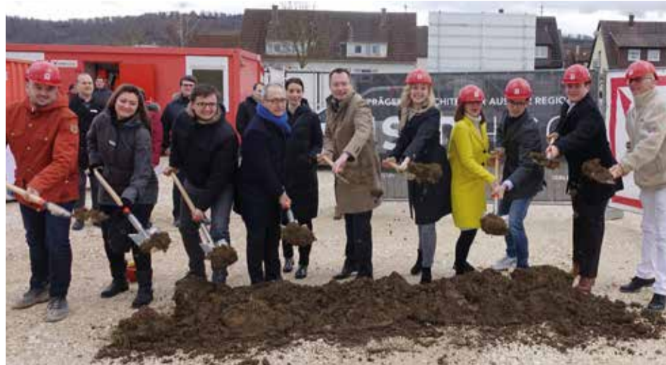
OB Thilo Rentschler hat mit den beteiligten Projektpartnern und künftigen Nutzern des MVZ den Startschuss zum Bau gegeben.
