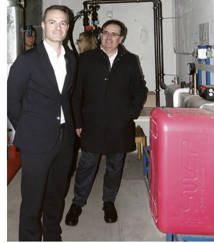
Oberbürgermeister Frederick Brütting und Erster Bürgermeister Wolfgang Steidle mit der neuen Nahwärme-Anlage des Bauhofs. Foto: Stadt Aalen
