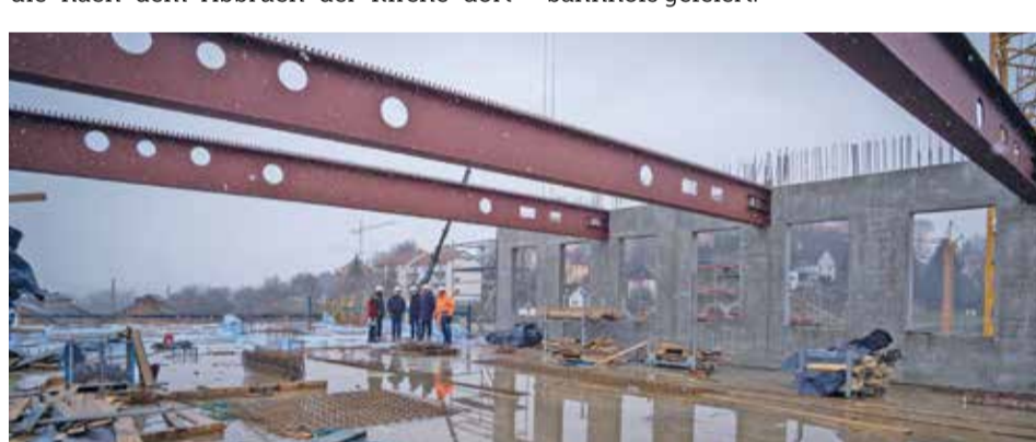
Auf dem Dach des Kulturbahnhofs.
