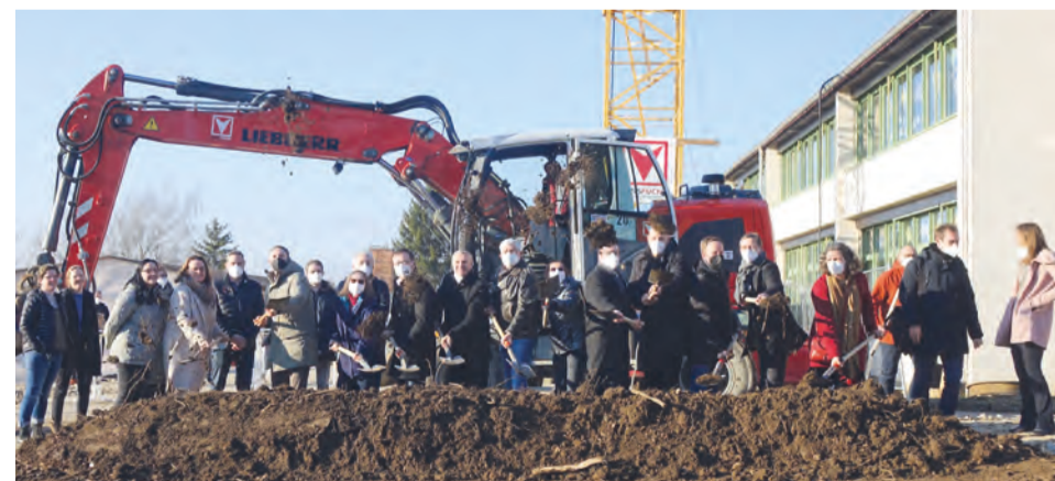
Bei strahlendem Sonnenschein fand der Spatenstich für die neue sechsgruppenige Kita auf dem Bildungscampus Braunenberg statt.
